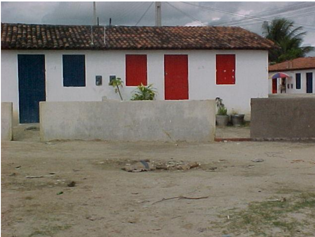
Foto 6 – Detalhe das casas.
