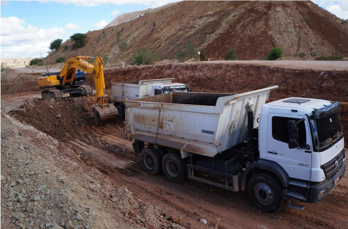
**Figura 3.1** - Escavação da nova rampa de acesso – *Open Pit Mining*.
