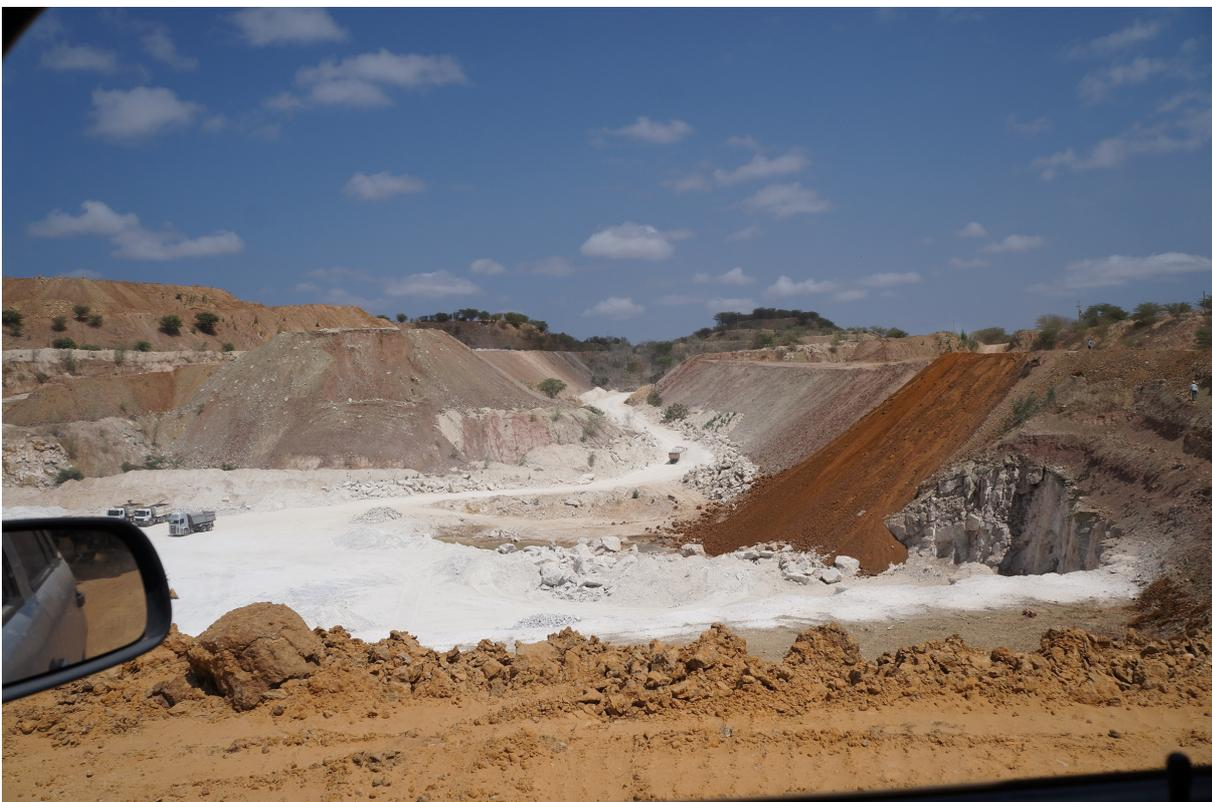
**Figura 3.2** – Deposição do material estéril – *Terrace Mining*.
