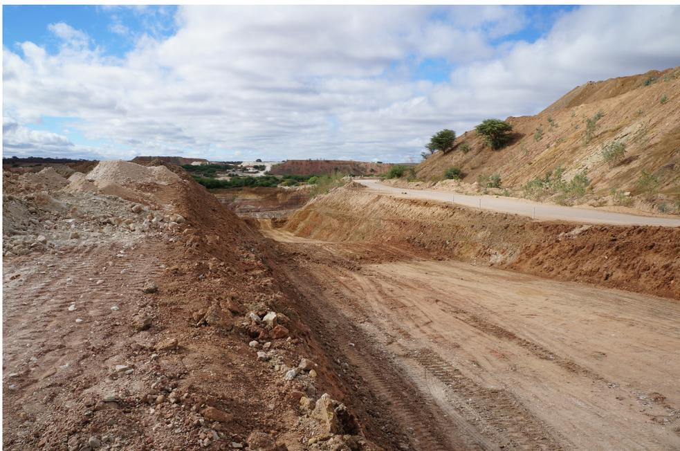
**Figura 4.11** - Rampa em desenvolvimento para aplicação do método *Terrace Mining*.
