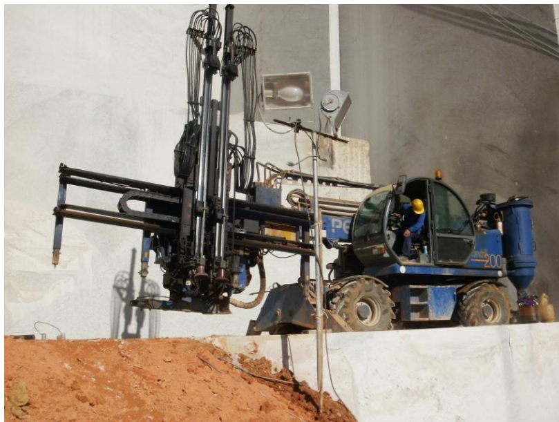
Figura 7.8: Carreta de perfuração de filões (Girodrill) se deslocando sobre a prancha.
