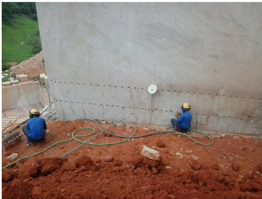
Figura 4.3: Operário realizando o carregamento da "boca de lobo".
