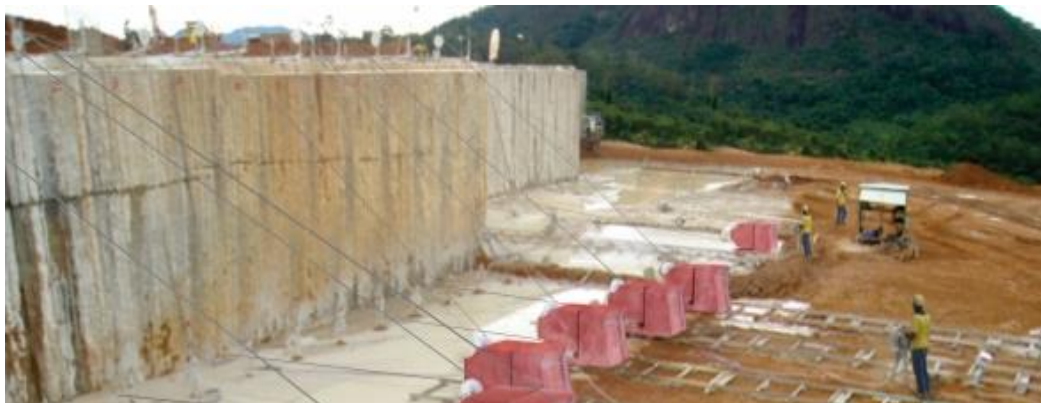
Figura 2.1: Máquinas de fio diamantado realizando corte no maciço rochoso (Fonte: Co.Fi.Plást)
