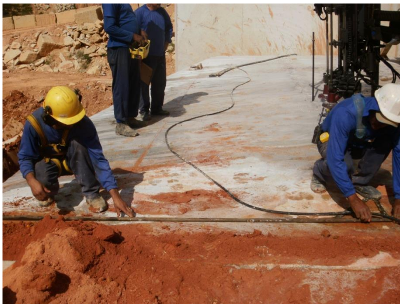
Figura 7.3: funcionários realizando as marcações do esquadrejamento.
