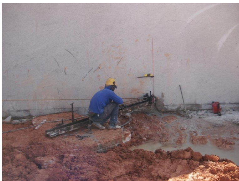
Figura 4.2: Perfuração horizontal sendo realizada.
