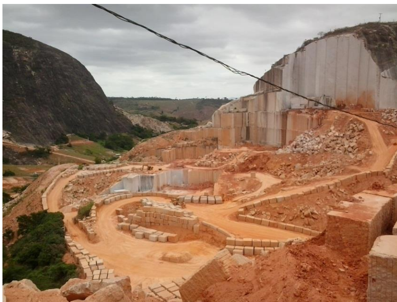
Figura 7.12: Depósito de estocagem de blocos da frente F1.
