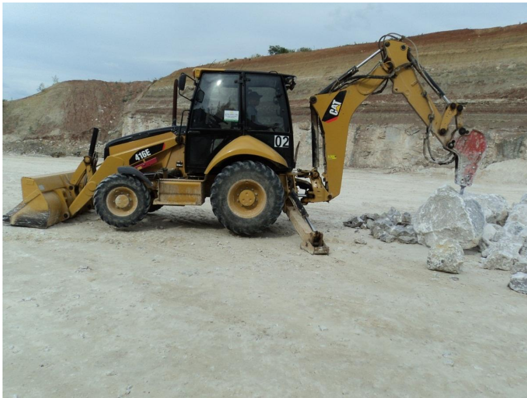
Figura 3.3 - Retroescavadeira sobre pneus executando o desmonte secundário com rompedor hidráulico
