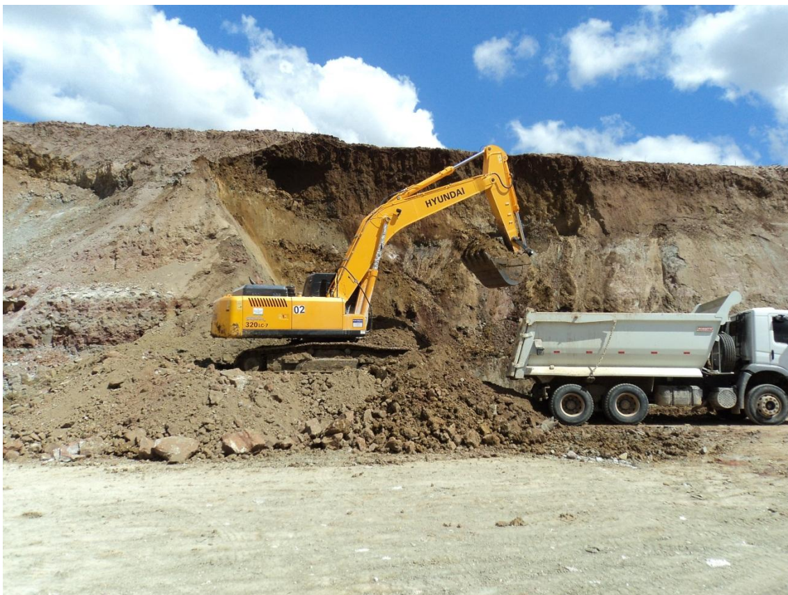
Figura 3.2 - Operação de descobertura com uso de escavadeira hidráulica sobre esteiras
