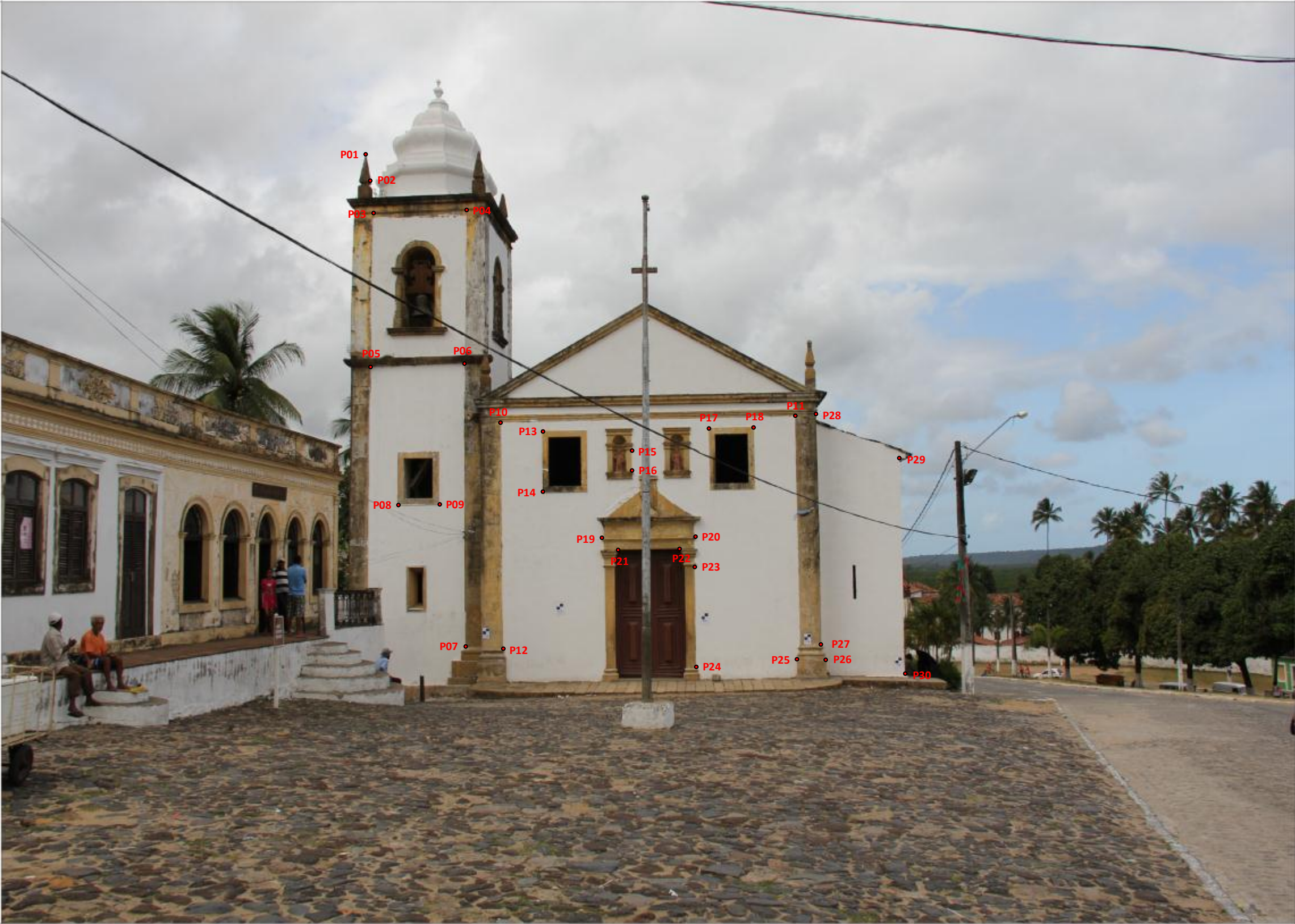
ANEXO H - Esquema utilizado para definir a localização dos pontos de medições sobre o objeto de estudo 2
