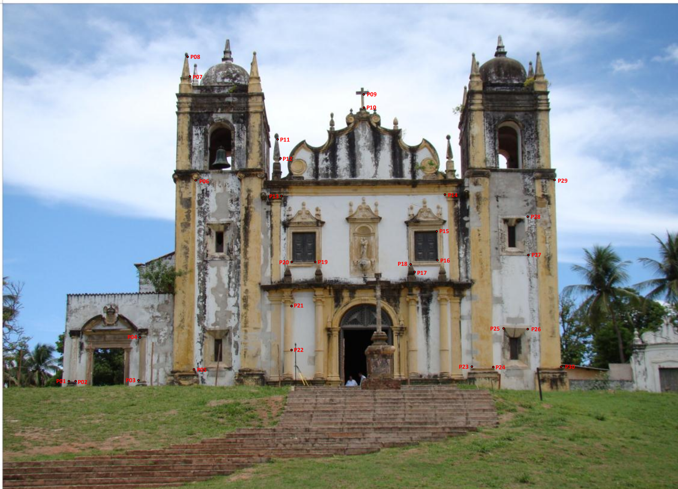
ANEXO I - Esquema utilizado para definir a localização dos pontos de medições sobre o objeto de estudo 3
