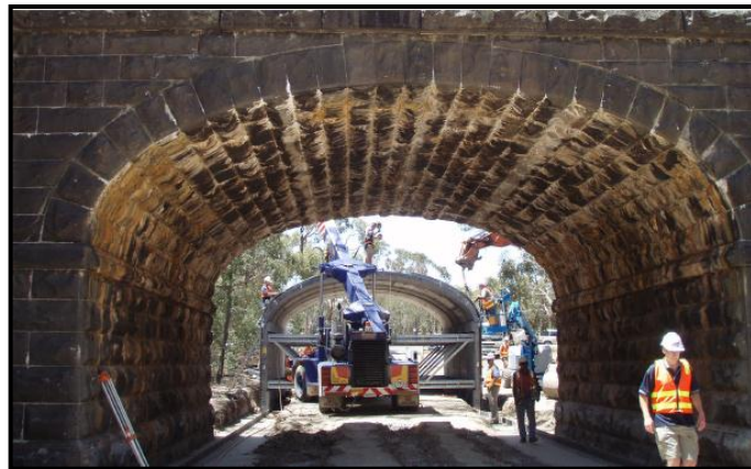
Figura 20 - Forro de concreto pré-moldado pronto para correr sobre um trilho.
