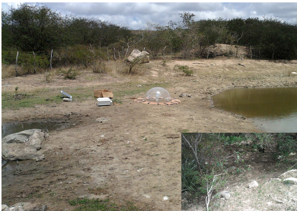
Figura 22: Vista panorâmica da barragem em Venturosa juntamente com o domo, o painel solar e a caixa com a central de aquisição de dados. O detalhe mostra um ponto em que a barragem “complementada” com solo e pedras, com o intuito de obter uma região alagada em períodos de maior abundância hídrica.
