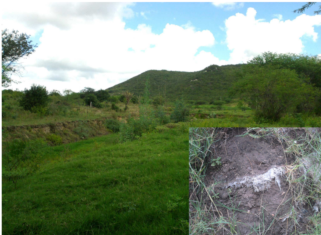
Figura 21: Vista panorâmica da barragem cafundó II, em mutuca, Pesqueira. No detalhe, temos um ponto em que a barragem sofreu um rompimento provocado por chuvas acima da média.
