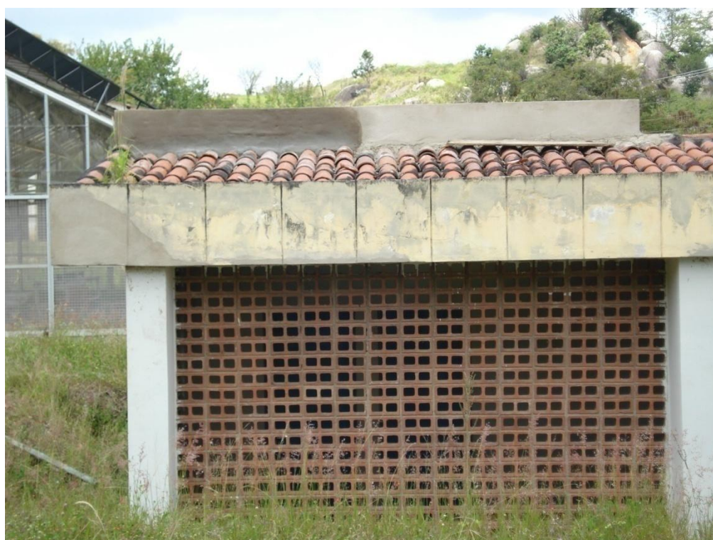
(b) Edificação existente no IPA onde foram instalados os telhados verdes.
