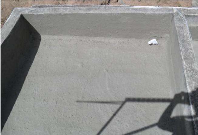
(d) Fissuras ressurgidas após o 1º teste de estanqueidade.
