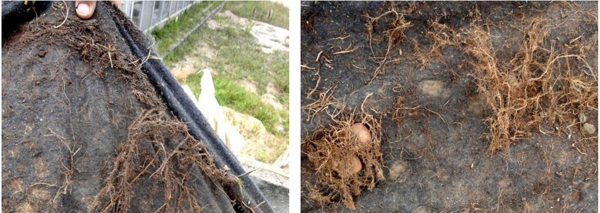
As raízes da vegetação utilizada estavam ultrapassando a camada de proteção e atingindo a laje da construção provocando fissuras na camada impermeabilizante da mesma. Na camada drenante, além da argila expandida, verificou-se a presença de grande quantidade de areia, provavelmente oriunda da camada de substrato, e a presença de alguns aracnídeos de grande porte como a *Lasiadora SP* (Figura 17).
