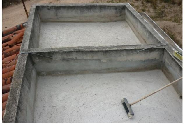
(c) Aplicação de revestimento impermeável sobre a camada de argamassa.
