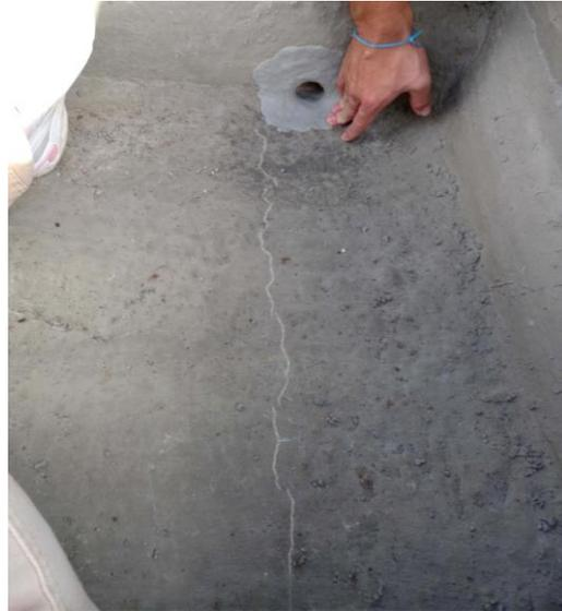
Figura 20- Aplicação do adesivo estrutural nas trincas e fissuras.
