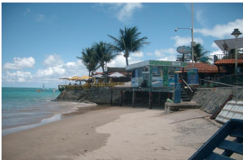
Figura 76(9) - Erosão costeira em Porto de Galinhas.
