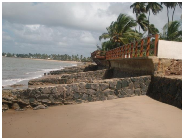
Figura 56(6) - Espigões e muros de contenção na Praia de Toquinho.
