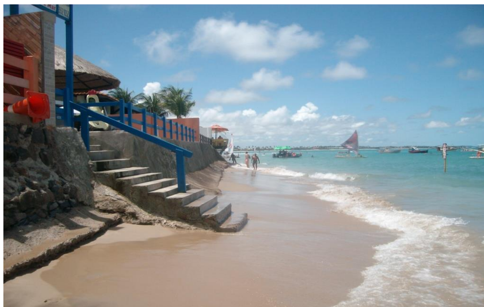
Figura 69(8) - Estruturas de muros e rampas construídas pelo homem sem controle ou fiscalização.
