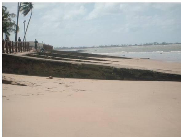
Figura 57(6) - Sedimentos acumulados entre as rampas na Praia de Toquinho.
