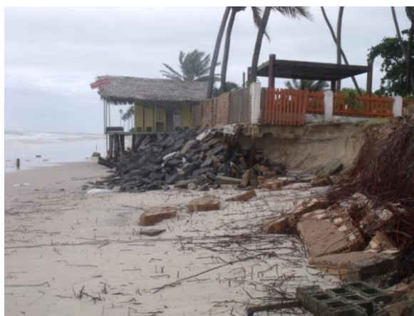
Figura 46(6) –Construções destruídas em decorrência dos intensos processos erosivos na Praia de Maracaípe, Ipojuca- PE.
