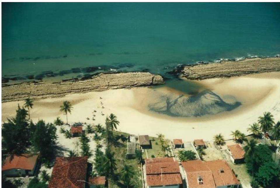
Figura 23(4) - Vista aérea de uma erosão de praia provocada pela ação das ondas, em área onde se constata uma descontinuidade (quebra) no recife de arenito. Toco Grande – PE.
