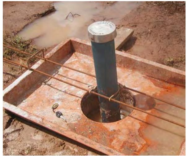
**Figura 4.4** - Aspecto do revestimento interno e tampão do poço, antes da construção da caixa de proteção.
