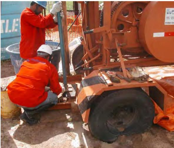
**Figura 4.3** - Operação de instalação do revestimento em PVC geomecânico.
