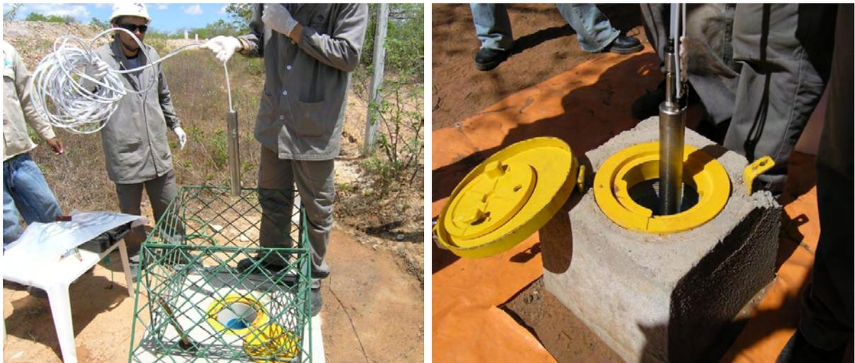
**Figura 5.1** - instalação da bomba de bexiga no poço.
