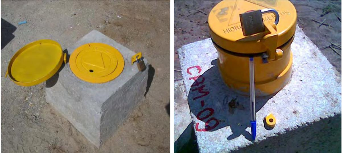
**Figura 4.5** - Poço de monitoramento concluído na área de Canto do Amaro, com detalhe da caixa de proteção construída ao redor da boca do poço.
