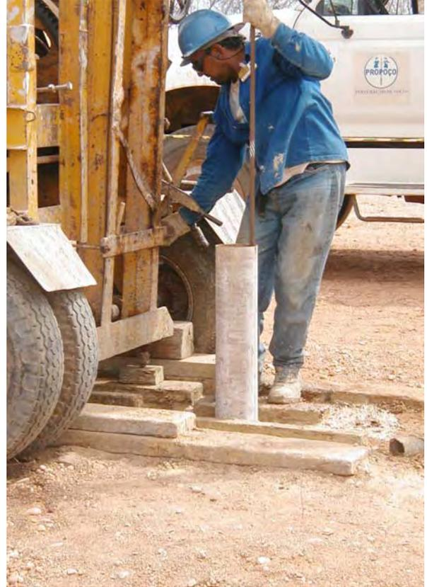
**Figura 4.2** - Revestimento provisório de 6'' em ferro galvanizado utilizado na execução de sondagem na área de Canto do Amaro.
