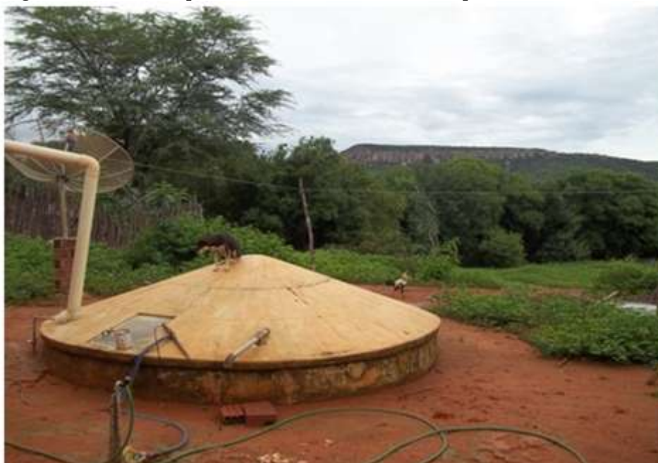
Figura 23. Cisterna implantada numa das residências no povoado do Barreirinho.
