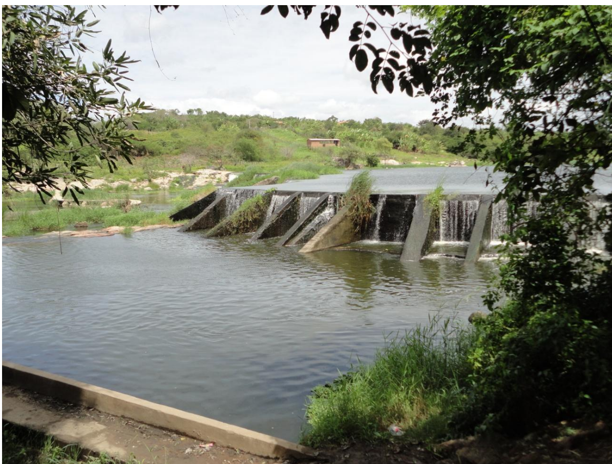
Figura 3.19- Barramento no rio Capibaribe- Açude Edilson. Fonte: Barbosa, julho/2011.
