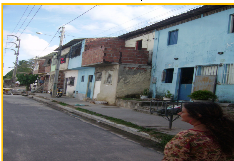
Foto 14 — Casas no Estilo Duplex Conjugadas no Conjunto Habitacional do Jacarezinho que Sofreram Reformas
