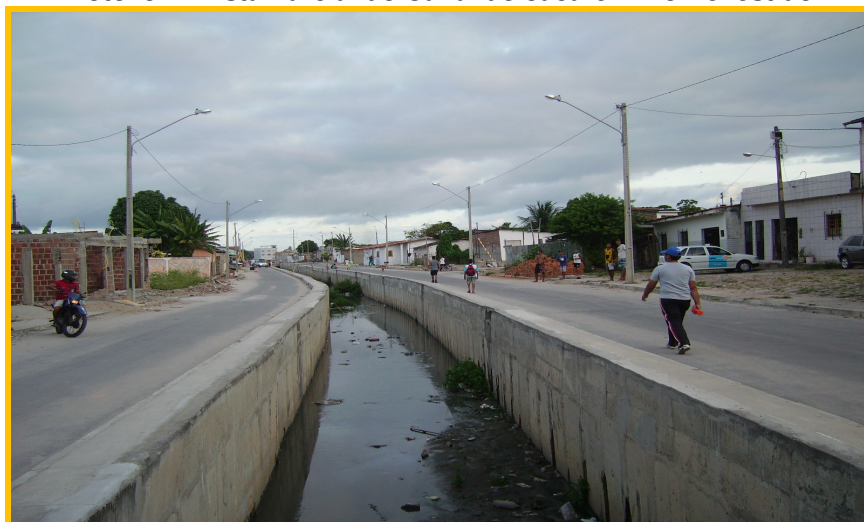
Foto 8 — Vista Parcial do Canal do Jacarezinho Revestido
