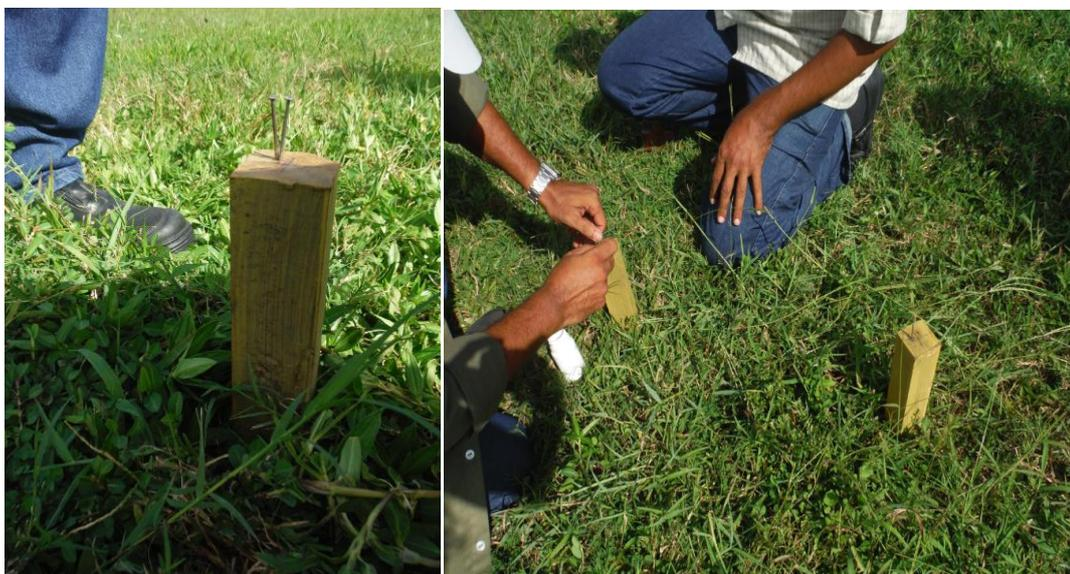
Figura 69 – Fixação dos pregos nos pontos e amarração do fio a “nylon”.
