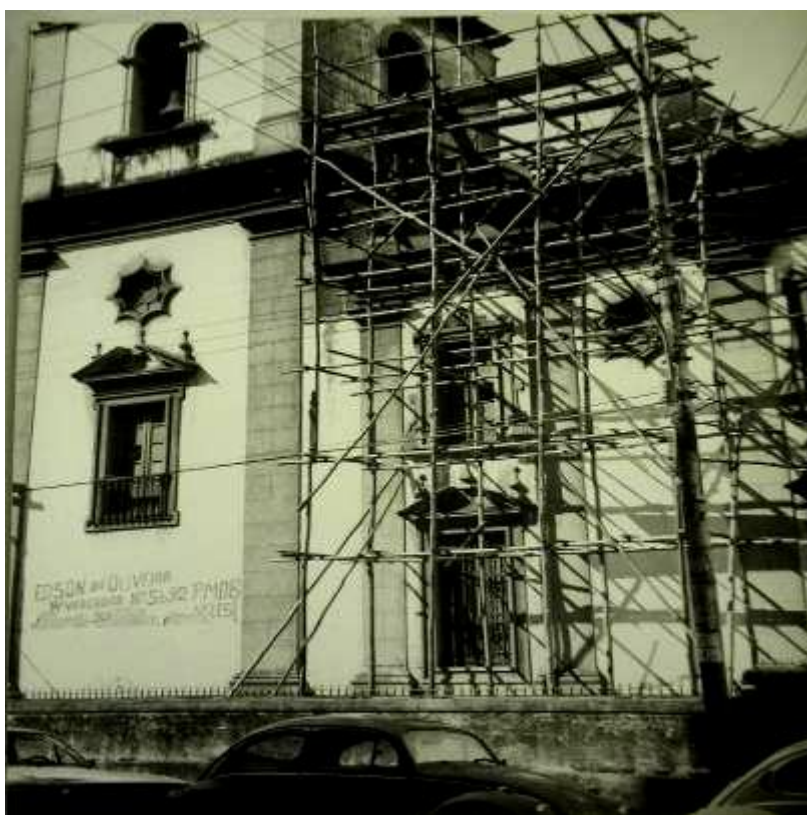
Fotografia 19 Igreja da Madre de Deus pichada, centro de Recife, 1983 289 .
