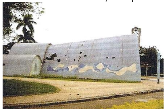
Figura 9: Igreja da Pampulha, descamação das pastilhas.
