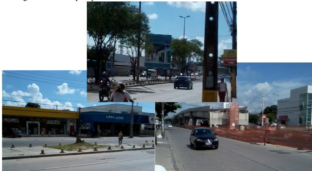
Figura 17 – Composição de fotos – Corredor Exclusivo de Ônibus Leste-Oeste
