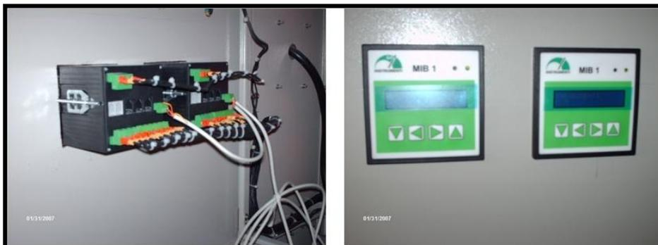
**Figura 3. 22 - IHM do medidor de parâmetros elétricos.**
