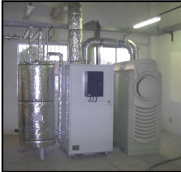
***Figura 3. 4 - Da direita para esquerda: Turbina, recuperador de calor e acumulador térmico.***
