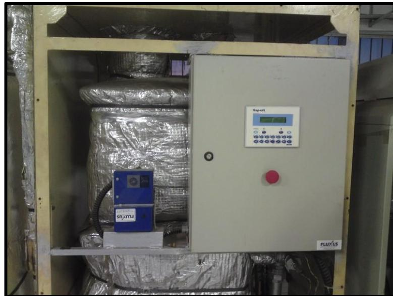
*Figura 3. 17 - Detalhe do CLP Expert (dir.) e atuador elétrico do damp.*
