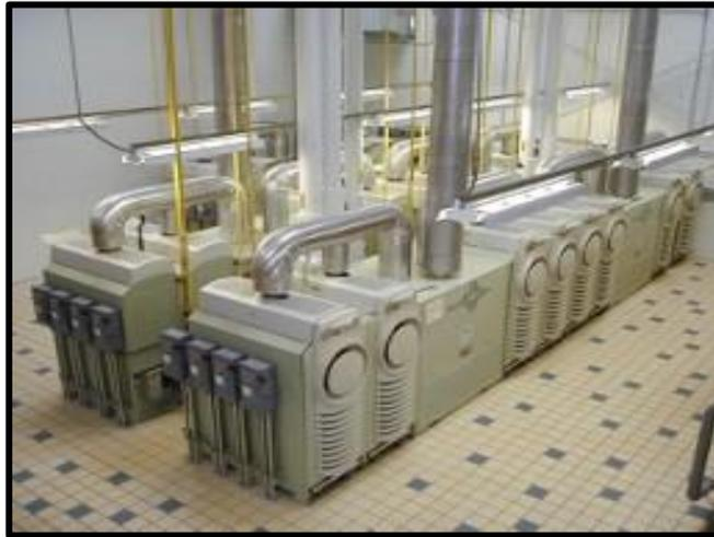
***Figura 3. 12 - Instalação de cogeração com 25 turbinas de 30kW (Harbec Plastics Inc, New York – EUA).***
