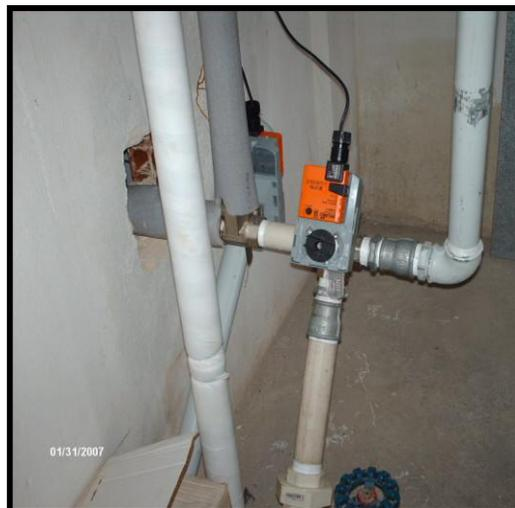
**Figura 3. 24 - Válvula três vias de controle de carga do show-room/câmara.**
