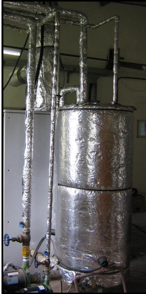
*Figura 3. 18 - Tanque acumulador térmico.*
