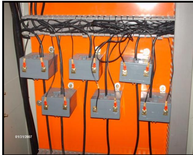
**Figura 3. 23 - TC (Transformador de Corrente) do medidor de parâmetros elétricos.**
