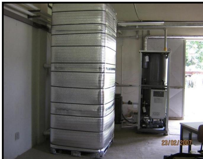
***Figura 3. 5 - Chiller de absorção e acumulador térmico de frio .***
