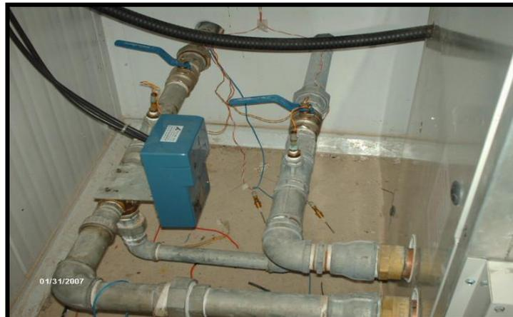
**Figura 3. 25 - Válvula três vias para controle de carga da câmara.**
