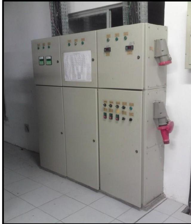
*Figura 3. 20 - Quadro elétrico geral do COGENCASA.*
