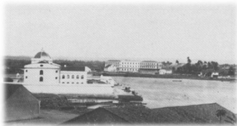
Figura 1: Casa de Detenção. Foto de Augusto Stahl, 1861. A frente voltada para o rio Capibaribe e ao fundo o Hospital Pedro II 80
