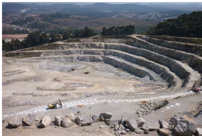
Figura 25 - Operação unitária de perfuração e desmonte por explosivo (etapa 2).
