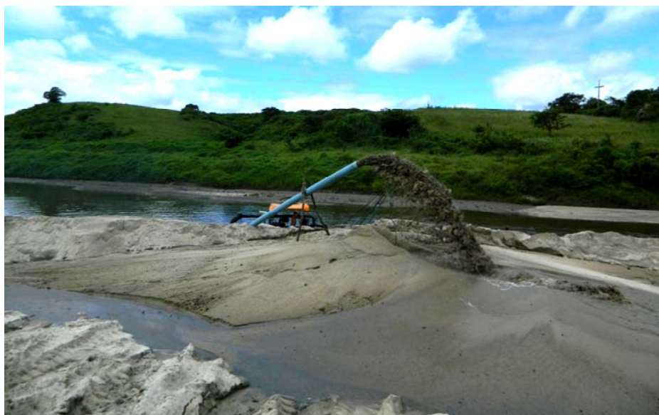
Figura 66 – Área produtora de areia, em leito de rio (depósito aluvionar, Rio Trairi em Monte Alegre (localidade de Quatro Bocas).
