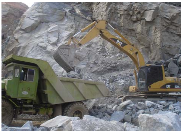
Figura 27 - Carregamento do material desmontado com escavadeira hidráulica (etapa 2).
