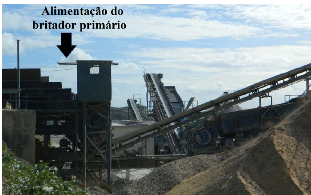
Figura 61 – Etapa de britagem e rebitagem, município de Macaíba (localidade Jundiaí, Pedreira Potiguar).
