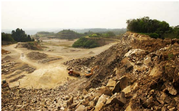
Figura 24 - Operações unitárias: determinação do local de exploração, limpeza e decapeamento (etapa 1).
