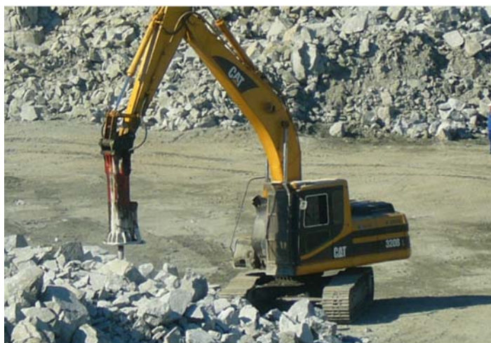
Figura 26 - Operação unitária adicional, desmonte secundário, por meio de rompedores hidráulicos.
