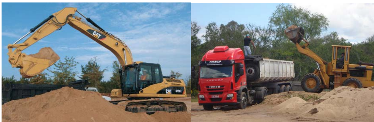
Figura 36 – Desmonte mecânico por escavadeiras ou tratores / pás-carregadeiras.
