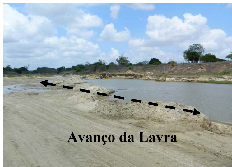
Figura 72 – Avanço da lavra ocorre longitudinalmente (no sentido do canal fluvial), Rio Trairí em Lagoa Salgada.
