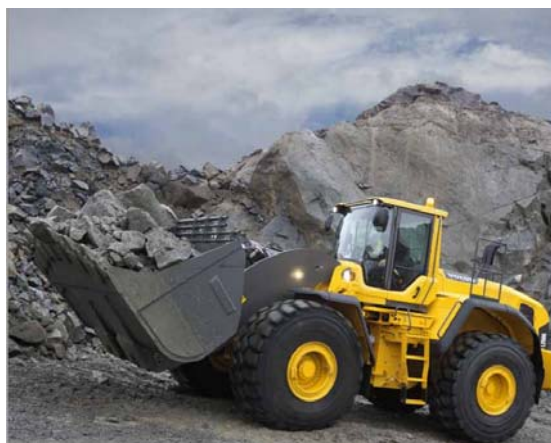
Figura 28 - Carregamento do material desmontado com pá-carregadeira (etapa 2).
