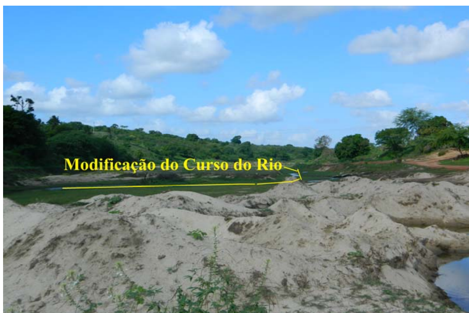
Figura 94 – Área de extração de areia na margem do Rio Potengi nos limites dos Municípios de Ilmo Marinho e São Gonçalo do Amarante (localidade de Pitombeira), evidências da modificação no curso e Redução da energia de vazão causada pelo processo erosivo.
