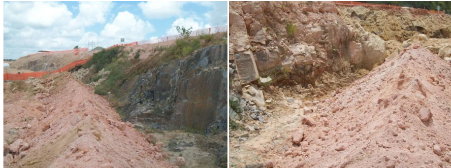
Fig. 3.4 – Afloramento gnaisse-granítico no interior da área de construção da Arena Pernambuco.
