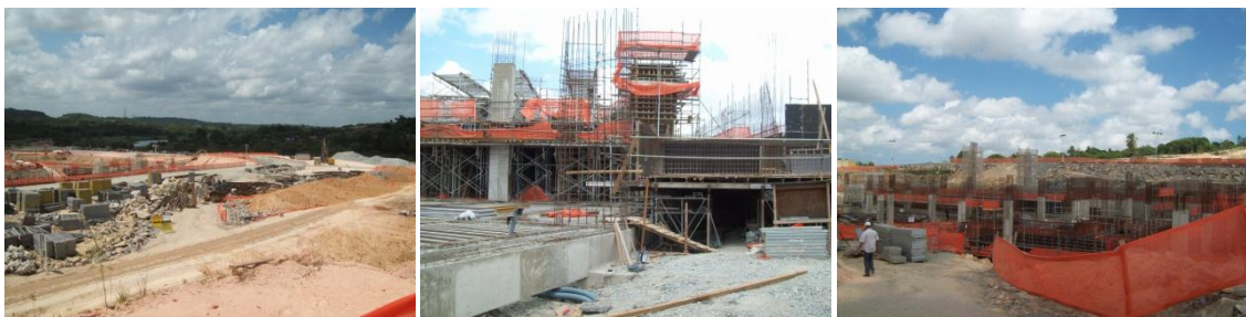
Fig. 3.5 – Estruturas já construídas na área da Arena Pernambuco passíveis de danos causados por vibrações.
