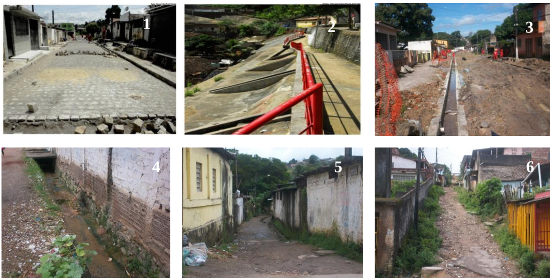
Figura 15 – a) Imagens do bairro de Caixa d'água. Área plana (1), vista da parte alta (2) e obras de saneamento (3); b) Imagens do bairro de Passarinho, onde, observa-se a ausência de saneamento (4, 5 e 6), características presentes em grande parte das ruas deste bairro.
