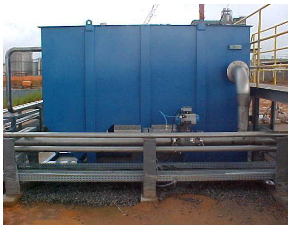
Figura 9: Caixa separadora de água/óleo Fonte: Autora (2012)
