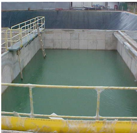
Figura 10 : Tanque de Equalização I Fonte: Autora (2012)
