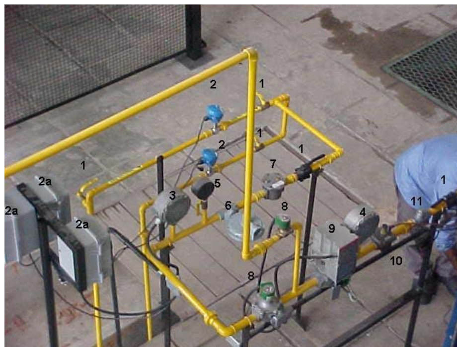
Figura 3.17 – Vista parcial do sistema utilizado na monitoração e controle das condições de combustão para o forno piloto
