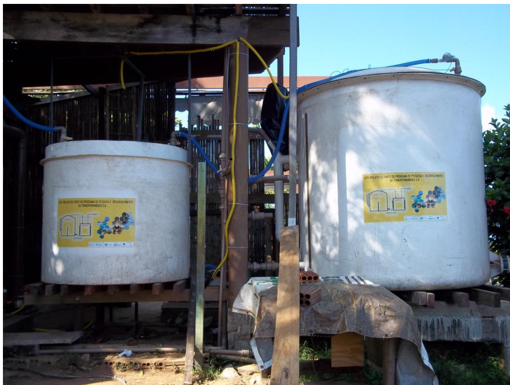
Figura 20 - Biodigestor instalado na pousada em Fernando de Noronha
