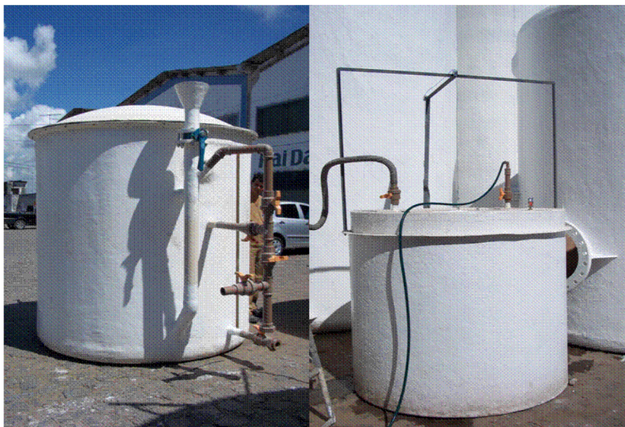
Figura 5 - Biodigestor (a) e gasômetro sem gás ou biogás (b).
