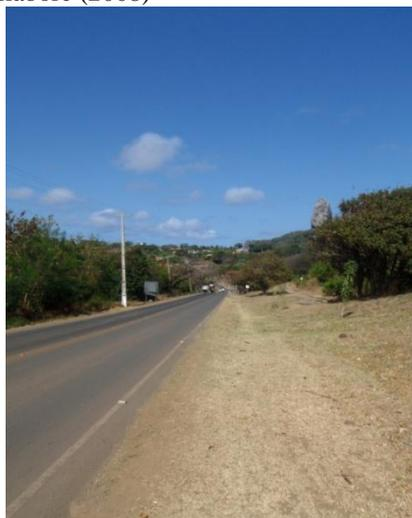
Imagem 37: BR 363 – ausência de acostamento adequado;
