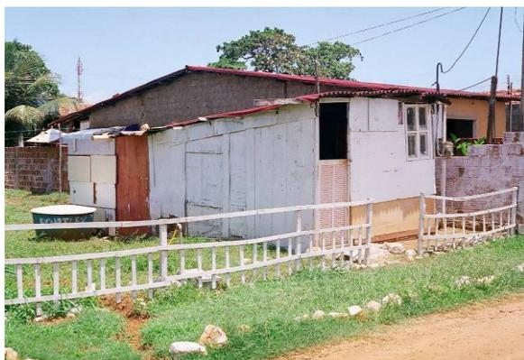
Imagem 12: Casa construída com sobras de materiais de construções;
