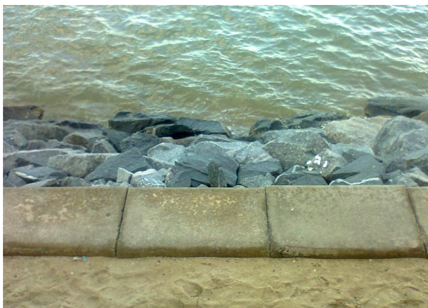
Foto 12: pós-praia artificial elevada protegida por enrocamento. Na maré alta o estrâncio é tomado pela água, impedindo o uso da praia.
