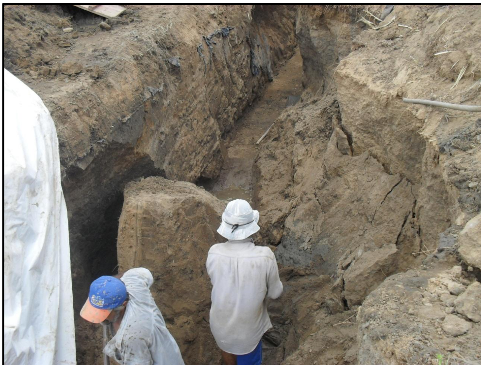
Figura 22. Entrada de água durante o preenchimento da vala da barragem subterrânea.
