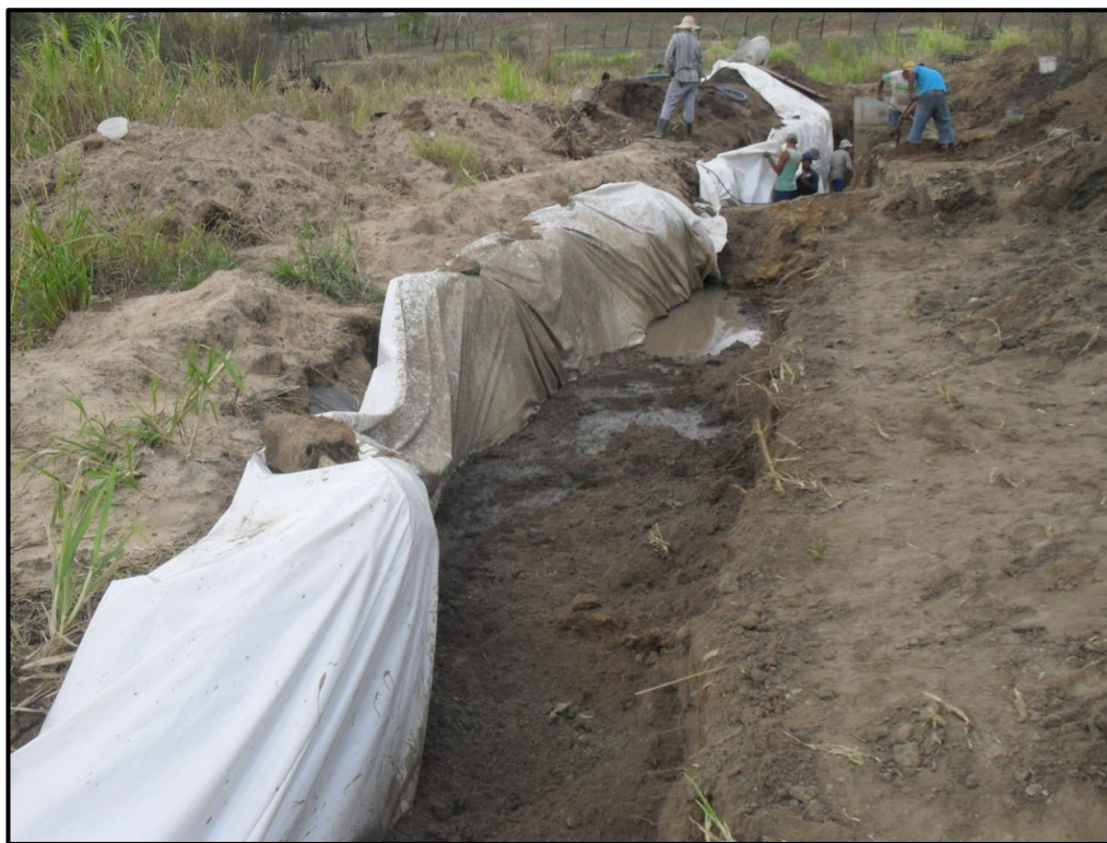
Figura 21. Entrada de água durante o preenchimento da vala da barragem subterrânea.
