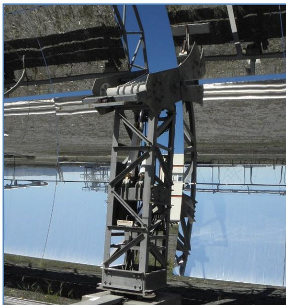
Figura 5 – Mecanismo hidráulico do sistema de rastreamento.
