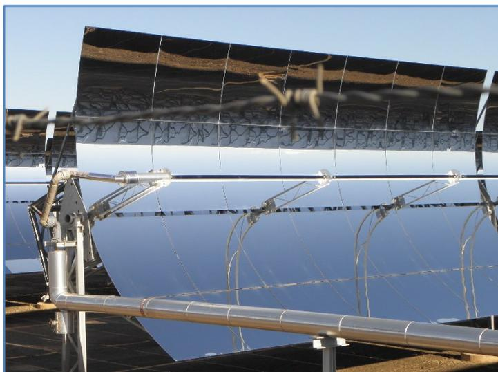
Figura 3 – Coletor cilindro parabólico (Planta Andasol 1 – Espanha).
