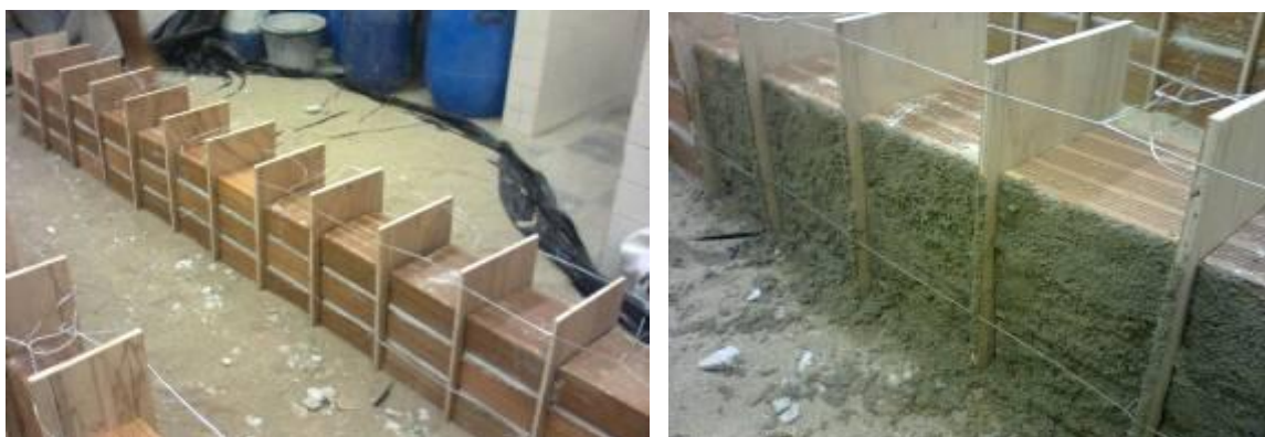
Figura 3.7 - Aplicação do chapisco para prismas ao chato
