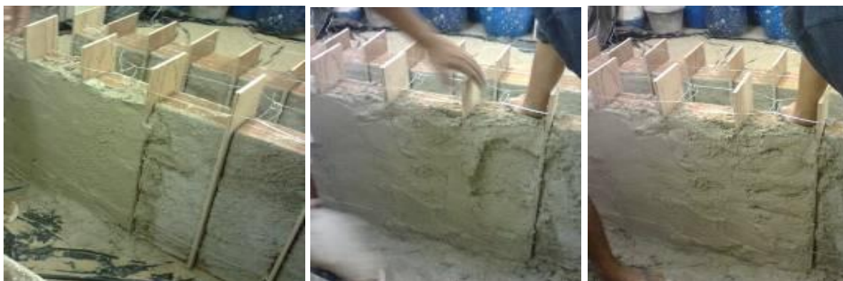
Figura 3.9 - Aplicação da camada de revestimento
