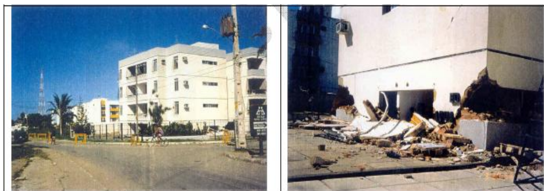
Figura 2.2 - Edifício Aquarela - Jaboatão dos Guararapes - PE
