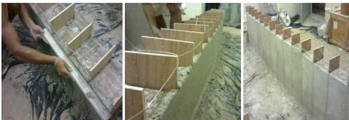
Figura 3.10 - Aplicação da camada de revestimento
