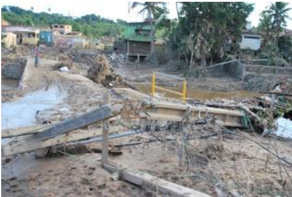
Figura 21: Imagem da ponte Baeté destruída pela enchente
