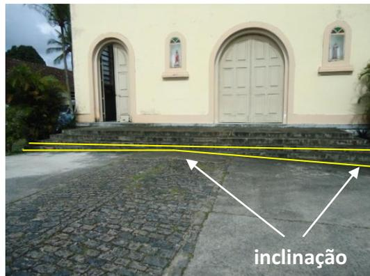
Figura 34: Inclinação no piso da faixa de pedestre
