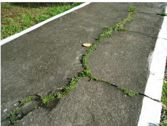
Figura 41: Vegetação no piso, gerando trincas
