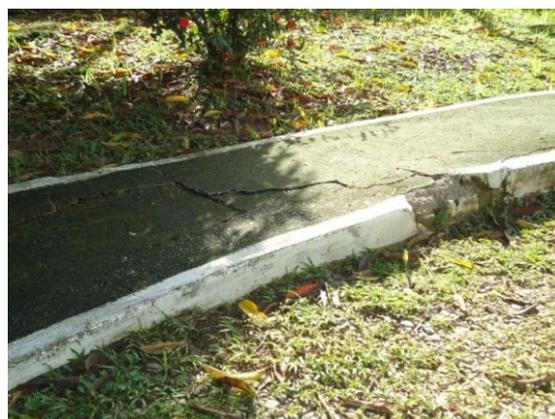
Figura 40: Tambo de inspeção com desnível
