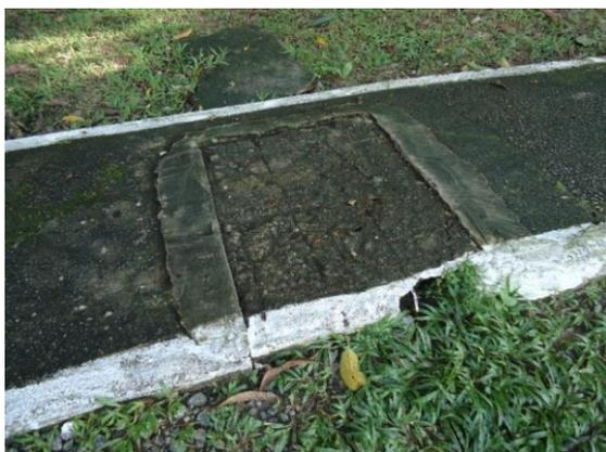
Figura 39: Meio-fio direito quebrado e trincas
