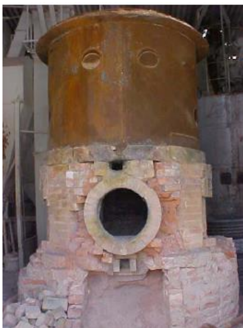
Figura 1-8 - Forno tipo panela.
