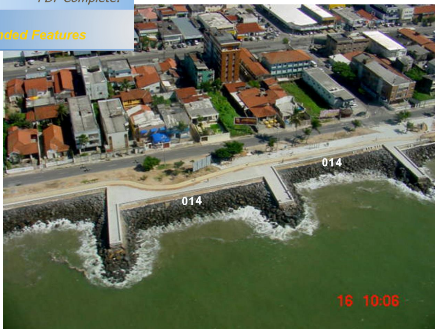
Figura 8-Espigões no Bairro Novo, município de Olinda (MAI, 2008).
