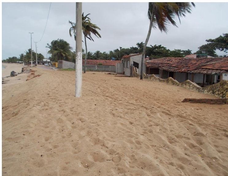
Figura 33 - Vista geral para sul do perfil 1.
