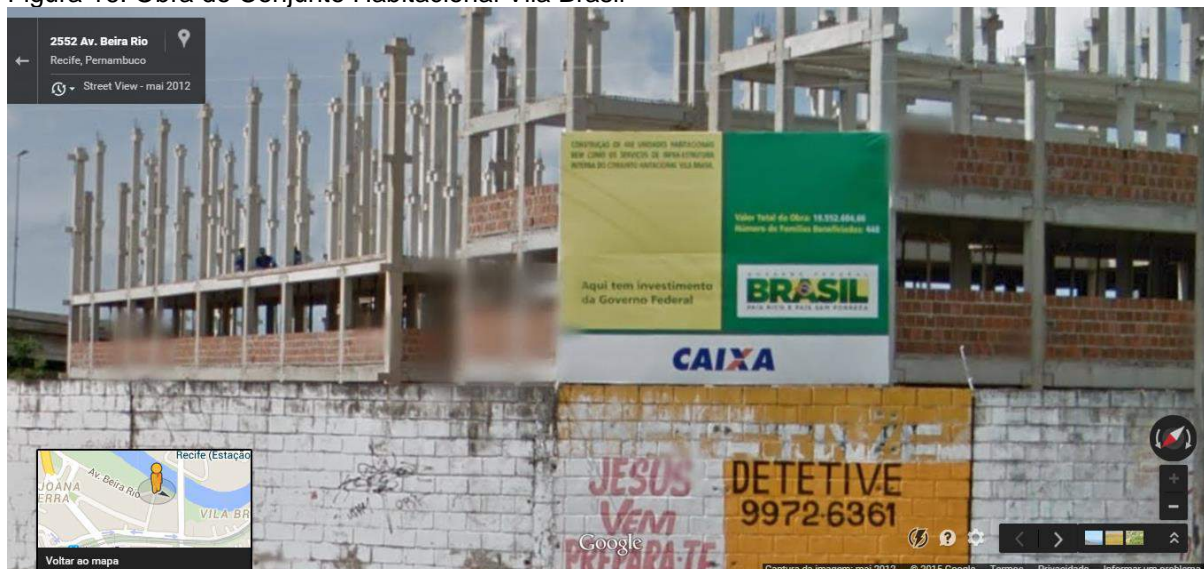
Figura 16: Obra do Conjunto Habitacional Vila Brasil
