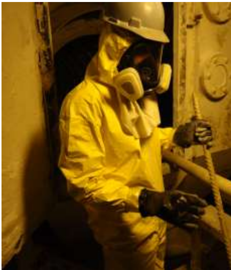
Imagem 2.1: Ferramentas para atividade na remoção de carepas do secador rotativo.
