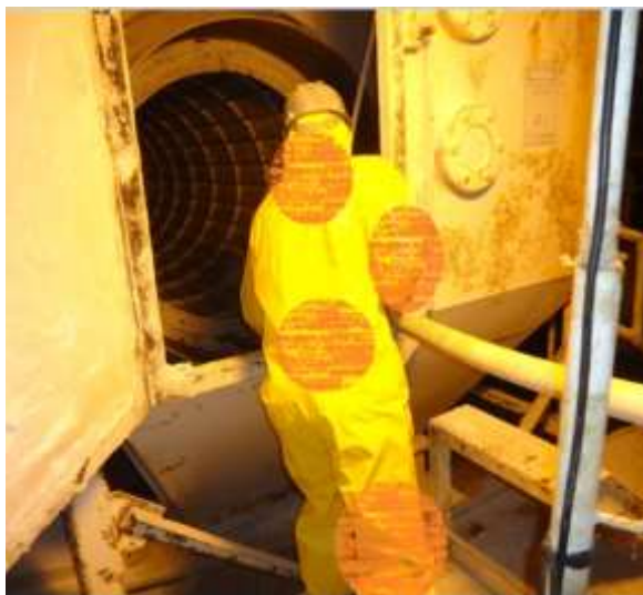
Imagem 2.3: Remoção de carepas do secador rotativo.
