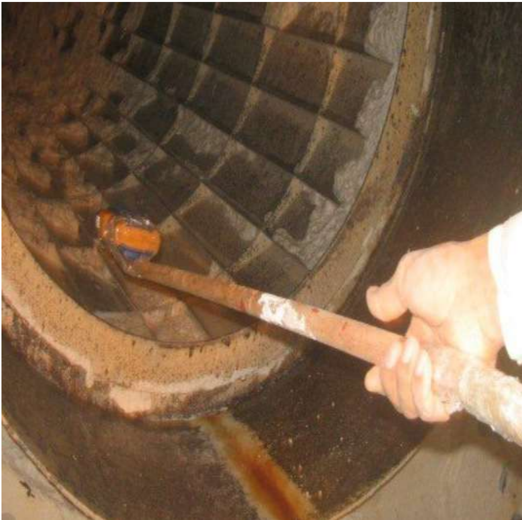
Imagem 2.8 : Inspeção para identificar a presença de contaminantes secador rotativo.
