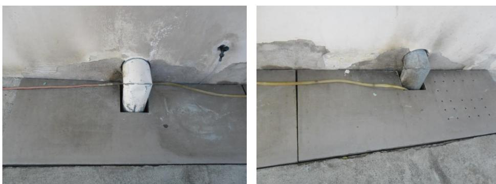
**Figura 47:** Caixas para retenção de felpas da lavanderia analisada
