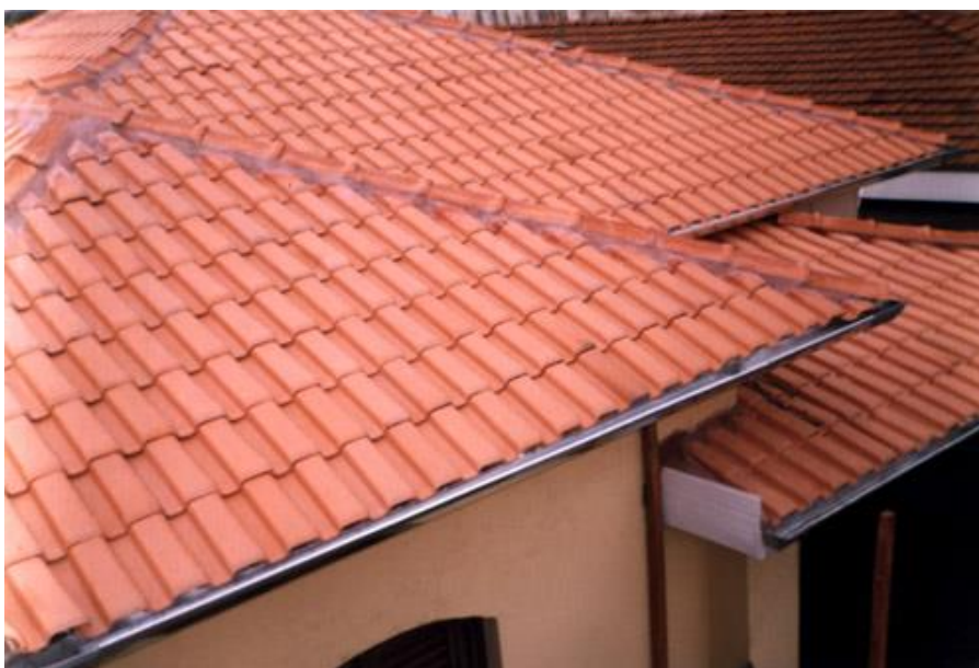
Figura 19 – Telha de cerâmica.
