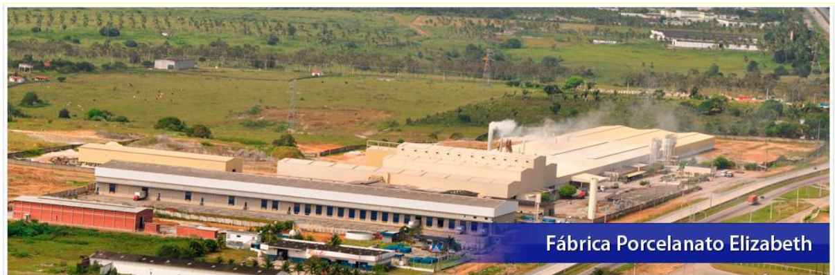
Figura 7 - Instalações da fábrica Elizabeth Porcelanatos
