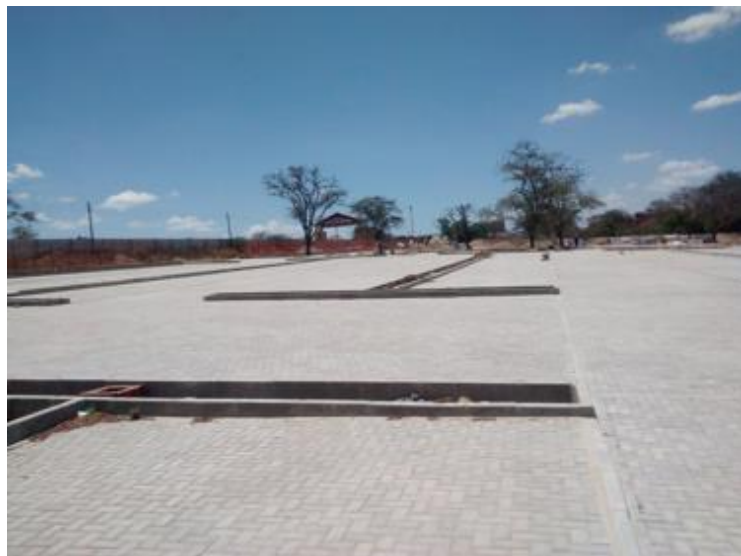
Figura 2 - Infraestrutura Turística do Alto do Moura (em construção), Caruaru - PE
