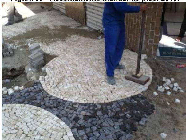
Figura 38 - Assentamento manual do piso. 2013.
