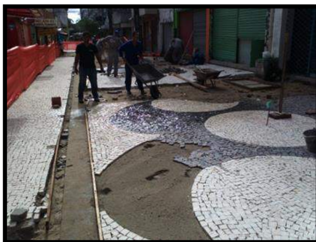
Figura 10 - Assentamento do piso. Fonte: Marcelo Pedrosa.2013.
