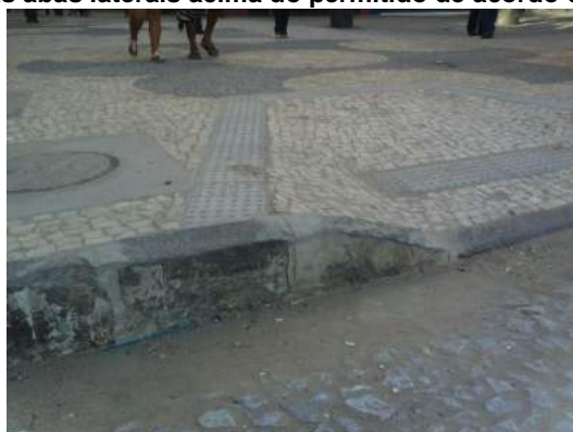
Figura 46 - A declividade das abas laterais acima do permitido de acordo com a norma brasileira. 2013.
