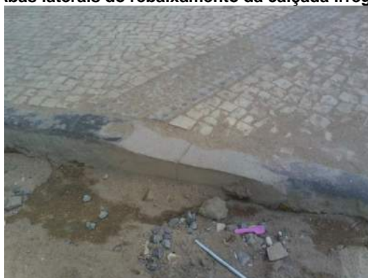
Figura 45 - Abas laterais do rebaixamento da calçada irregulares. 2013.
