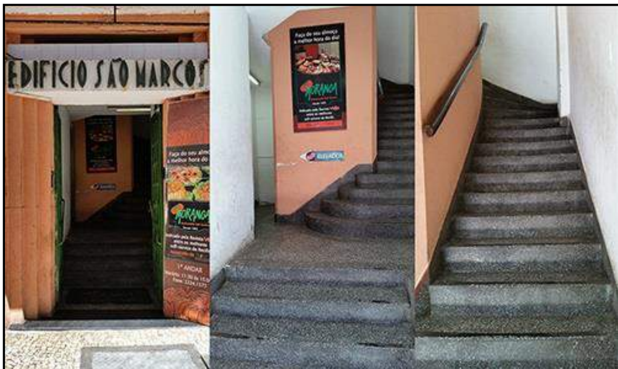
Figura 32 - Rota de acesso para o elevador impedido por escada sem sinalizações táteis e corrimãos irregulares. Fonte: Marcelo Pedrosa. 2014
