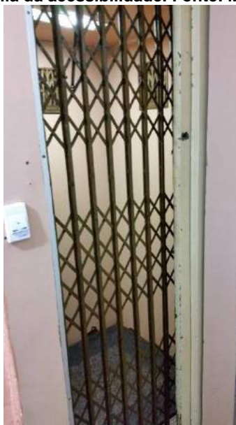
Figura 34 - Elevador não atende à norma do Mercosul nº.313/ 2007, entretanto, possibilita um alcance mesmo sem autonomia da acessibilidade. Fonte: Marcelo Pedrosa. 2015.
