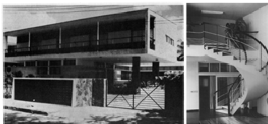
Fig. 10: Fotos fachada e escada da Residência Alfredo Lages 1954. Projeto Delfim Amorim. Fonte: Geraldo Silva Et. Al. 2ª Edição, 1991.
