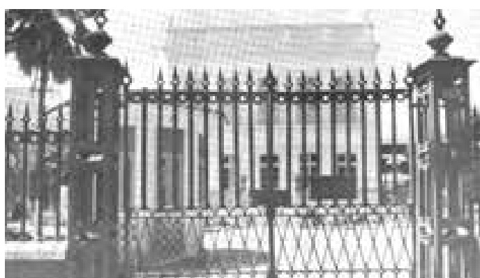
Fig. 04: Portão em ferro da casa nº 1426 da Av. Rui Barbosa, Recife - PE – Fundição d’Aurora, Século XIX. Fonte: MELLO, 1985, p. 107.
