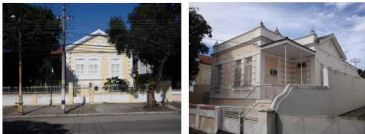
Fig. 3.19: Casa tipo 02, na esquina (à esq); e Casa tipo 01 (à dir). Possivelmente estas casas correspondem às duas “casas para oficiais”, registradas em 1909 na imagem anterior. Percebe-se pequenas alterações como, por exemplo, o fechamento da porta do alpendre e a instalação de ar-condicionados, ambas na casa tipo 01. Fonte: foto da autora (2012).
