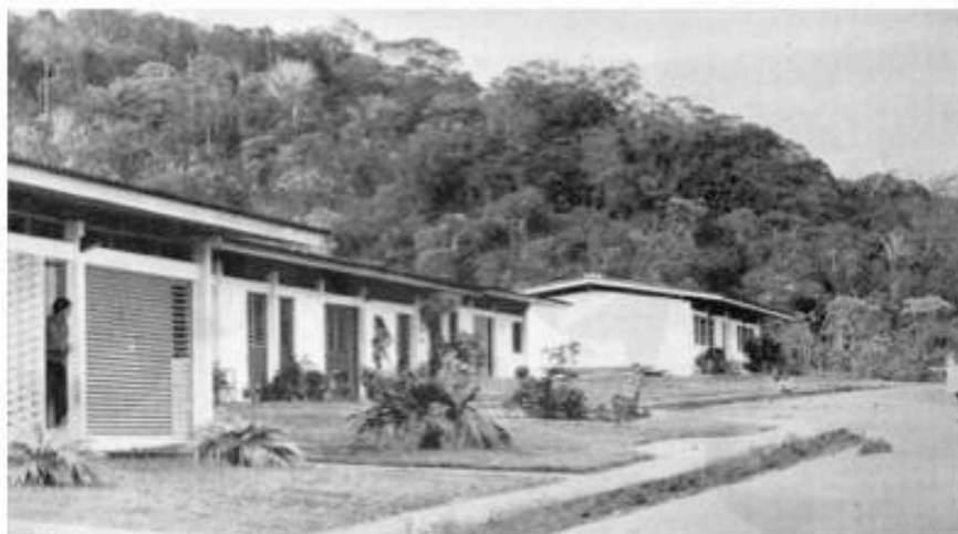
Fig. 6.19: Casas para operários no Vila de Serra do Navio de Bratke. Fonte: Bratke (1966).
