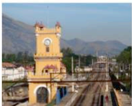
Fig. 3.13: Estação férrea da Villa Militar, de 1910.
