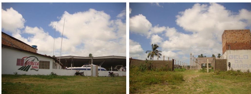
Figuras 29 e 30: Marina em funcionamento e em construção em Barra de Sirinhaém. Fonte: o autor.
