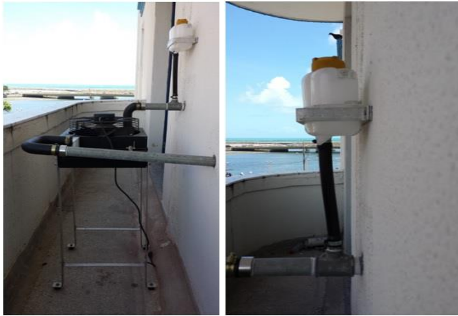
Figura20 – Trocador tipo radiador utilizado no arrefecimento das linhas de HT e LT do conjunto MCI-Gerador
