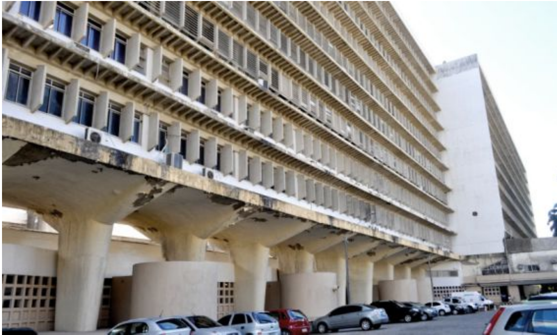
Fig.24 Horizontalidade das fachadas evidenciada pela estrutura de lajes e pilares em concreto armado. a. antiga Faculdade de Medicina. b. Centro de Tecnologia e Geociências. c. Hospital das Clínicas.
