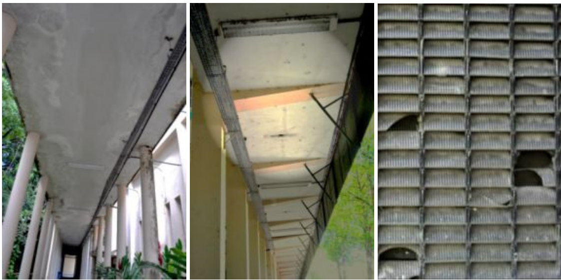
Fig.55 Aspectos de degradação física do CCS. a. passarela coberta. b. laje da circulação. c. parede de vidro.
