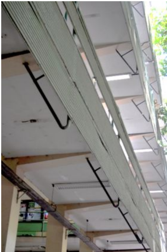
Fig.37 Brises em ferro da antiga Faculdade de Medicina.
