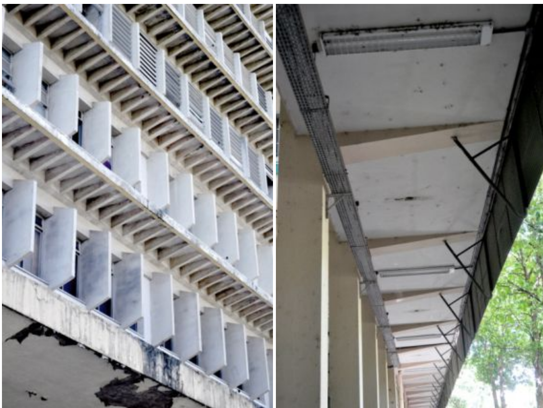
Fig.25 Diminuição da seção da estrutura nas extremidades. a. Hospital das Clínicas. b. antiga Faculdade de Medicina.
