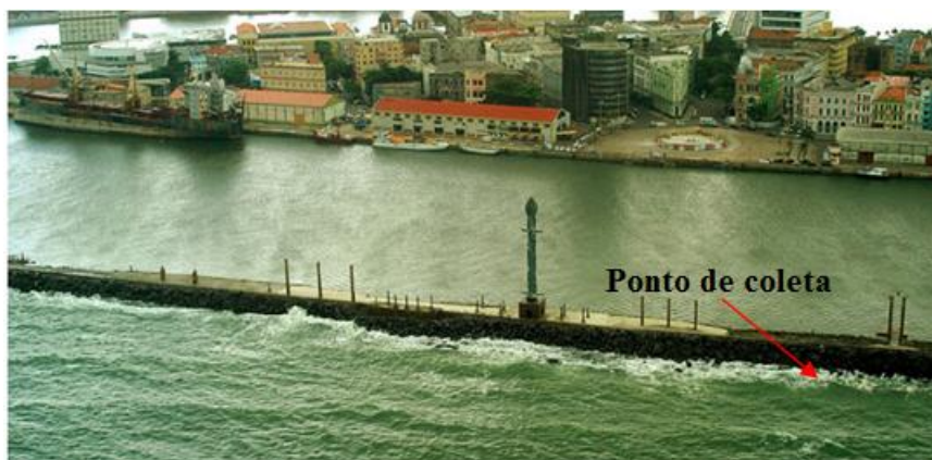
Figura 3.3 – Ponto de coleta da água no Porto o Recife. Foto: CEPE
