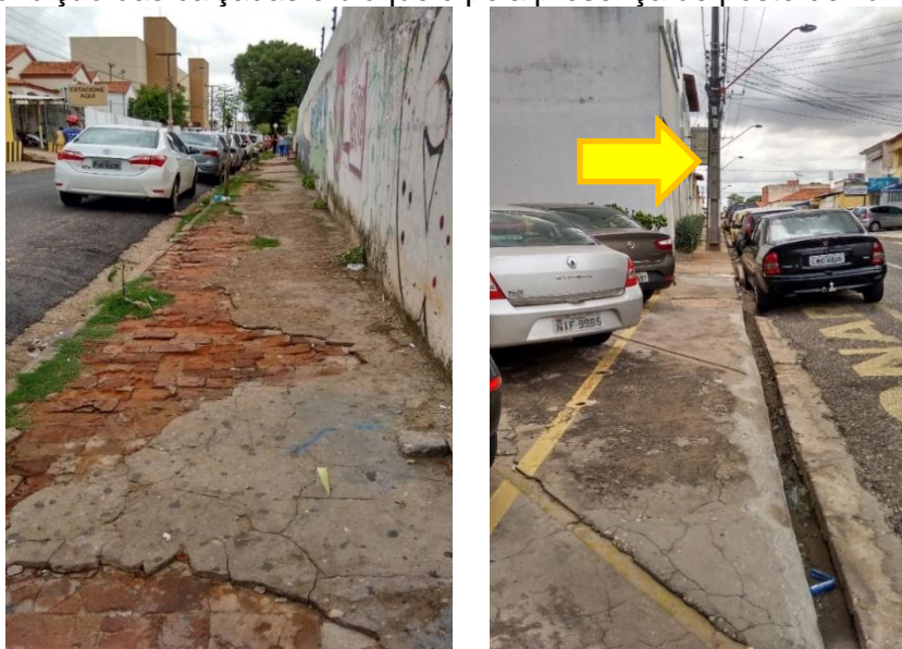
Figura 11 – Condição das calçadas e bloqueio pela presença de poste de iluminação
