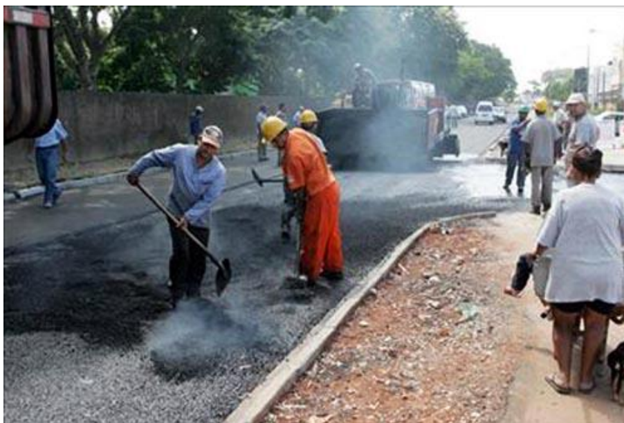
FIGURA 69. Aplicação do pó de borracha de pneu sendo adicionado ao ligante asfáltico.
