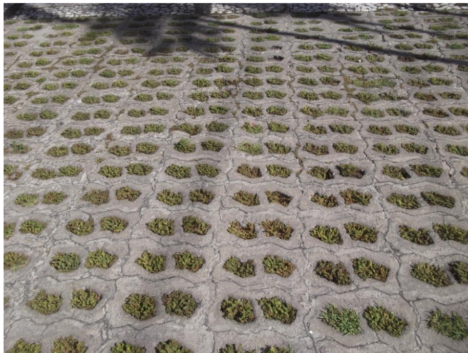
FIGURA 64. Imagem de superfície revestida por blocos permeáveis. Nesta imagem a estrutura treliçada, pré-fabricada foi construída a base de concreto.
