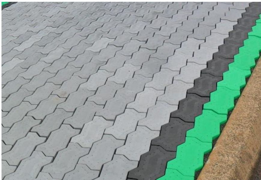
FIGURA 70. Aplicação do concreto ecológico, em substituição aos blocos intertravados na pavimentação de passeios urbanos.
