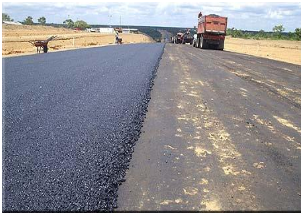
FIGURA 71. Aplicação da escória de aciaria misturado com o cimento para fabricação do concreto na pavimentação de estradas.
