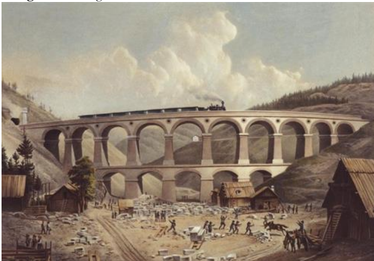
Imagem 08: Litografia do Viaduto Kalt Rinne.
