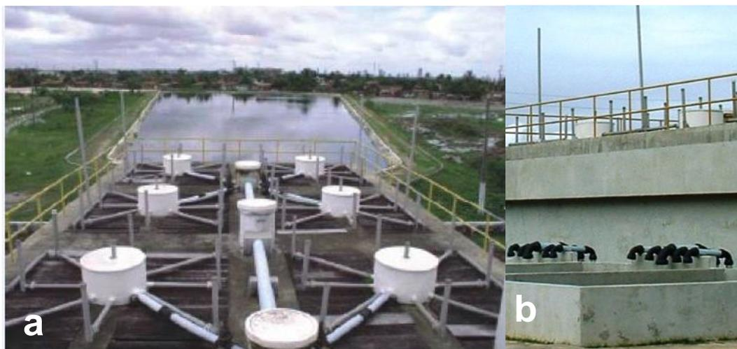
**Figura 8: ETE Mangueira, Reator UASB e Lagoa de Polimento(a) Leito de Secagem(b). Fonte: GPTA.**
