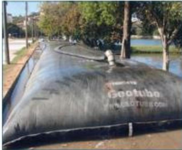
**Figura 5: Instalação de tubos de geotêxteis. Fonte: [www.allonda.com](http://www.allonda.com).**
